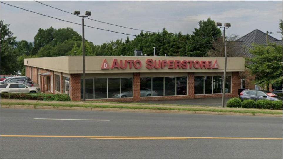
6. EXISTING CARLOTZ AUTO SUPERSTORE
